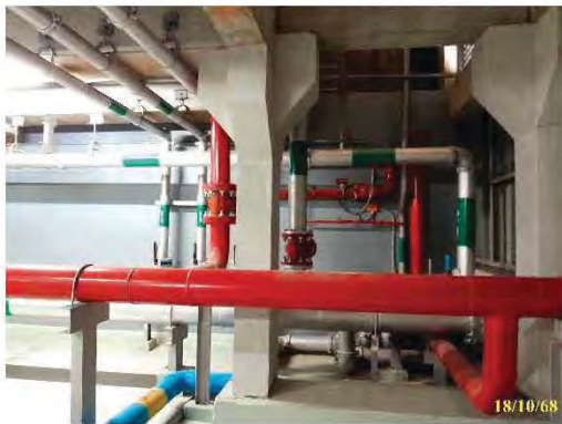
ถังเก็บน้ำชั้นใต้ดิน พร้อมเครื่องสูบน้ำชั้นใต้ดิน
