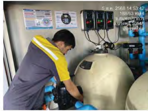
ตรวจเช็ค ระบบกรองสระว่ายน้ำ
