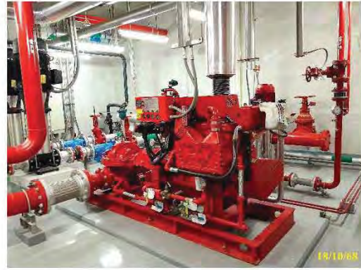
เครื่องสูบน้ำดับเพลิง (Pire Pump)
