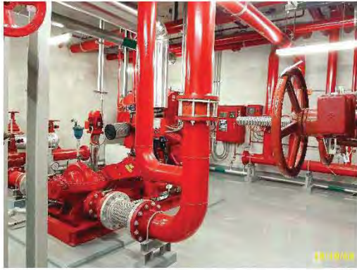
เครื่องสูบน้ำดับเพลิง (Pire Pump)
