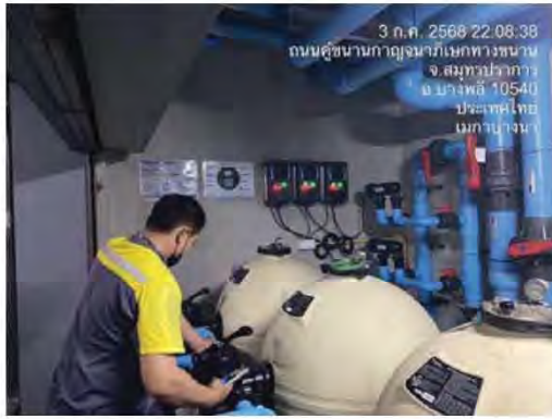
ตรวจเช็ค ระบบกรองสระว่ายน้ำ
